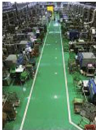
成形職場空調機の設置（名張工場）
